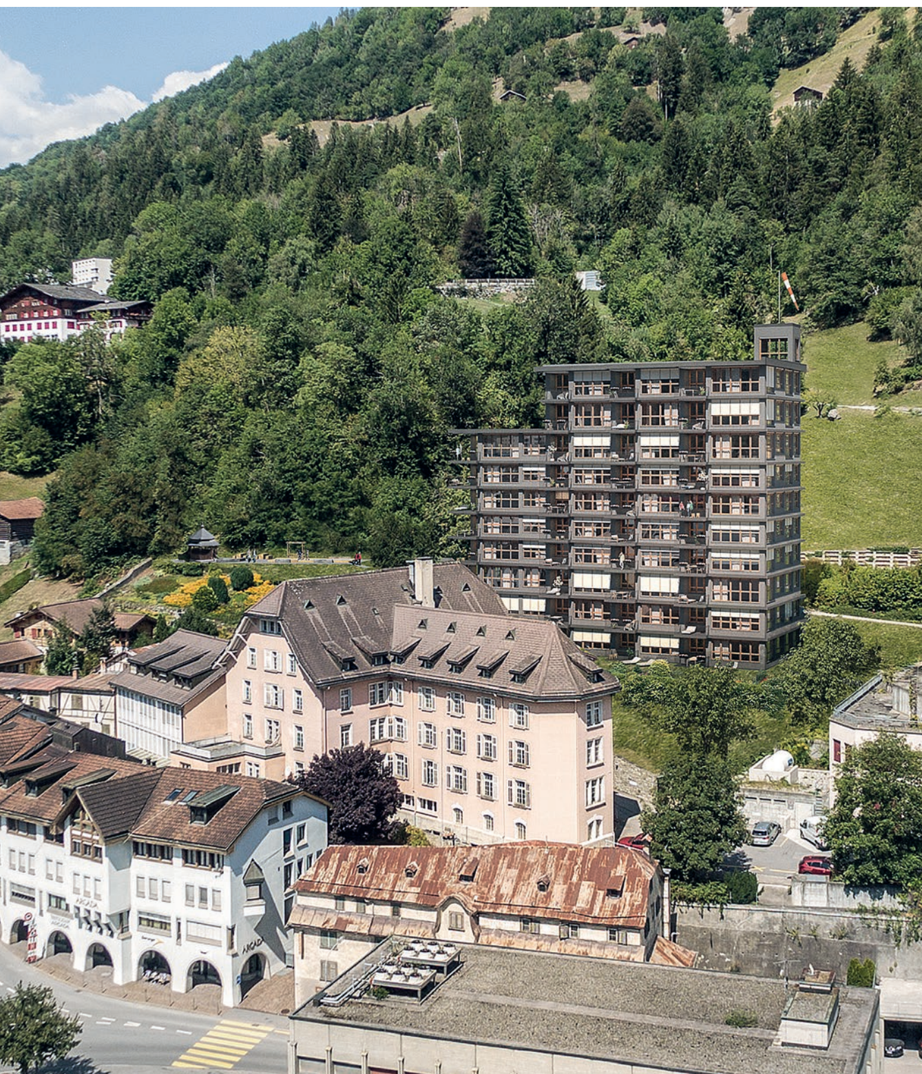
«Logements protégés»: À Ilanz (GR), un projet intergénérationnel comprenant 78 appartements est en train de voir le jour.
